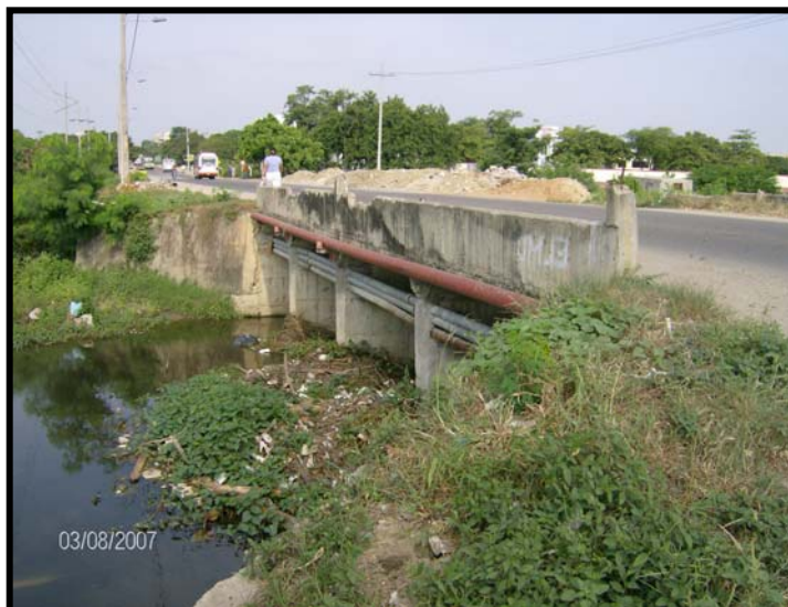
Foto D7.2 Box culvert: sobre el canal Matute sobre el tramo en estudio y al cual se le aplicaran las medidas descritas en éste programa.
