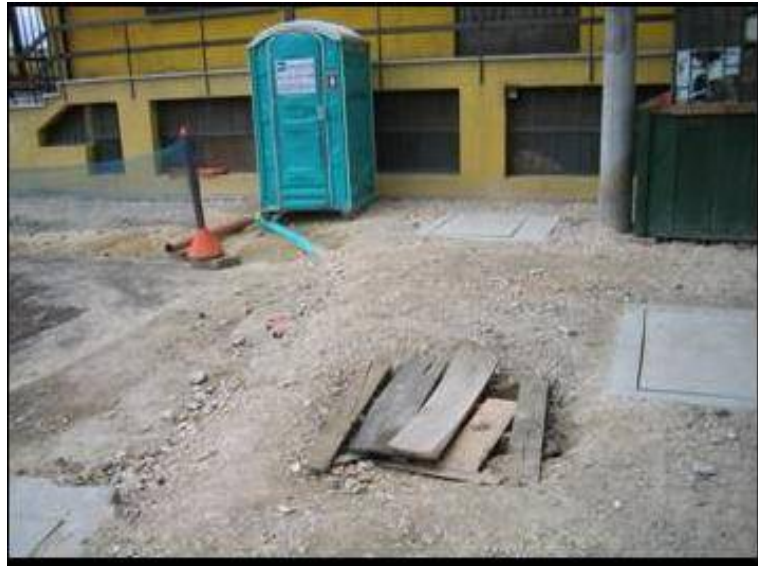
Foto D3.1 Todo campamento debe estar provisto de unidades sanitarias temporales (1 por cada 15 Trabajadores) (Adecuación de la Troncal NQS de Transmilenio en Bogotá)
