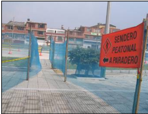
Foto D6.1 Señalización de Tránsito Peatonal
