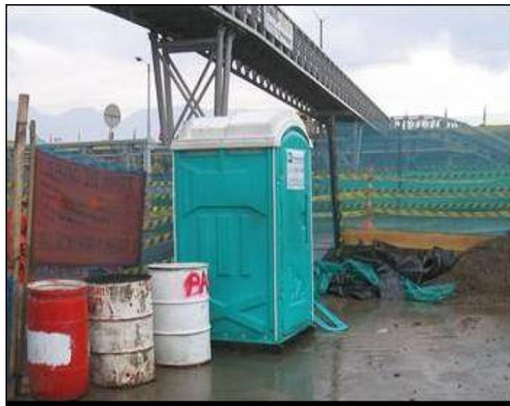
Foto D3.2 Se deberán colocar recipientes para la disposición de residuos sólidos en diversos puntos del campamento los cuales deberán ser diferenciados con colores con el fin de hacer clasificación de estudios en la fuente.
