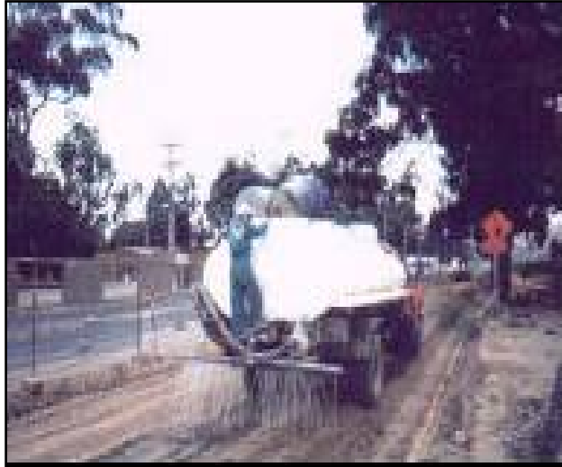
Foto D9.1 Para tiempo seco (días de no lluvia), y dependiendo el tipo de suelo y la eficiencia de humectación, se debe realizar humedecimientos por lo menos 2 veces al día, sobre las áreas desprovistas de acabados.
