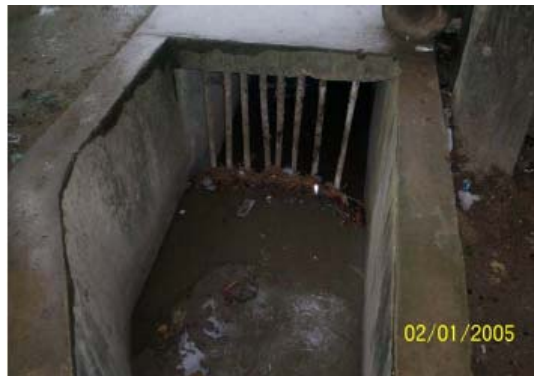
Figura 2.18. Inicio del box culvert paralelo a la vía
