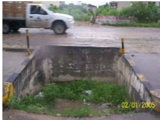
Figura 2.13. Vista del box culvert sobre abscisa K00+720
