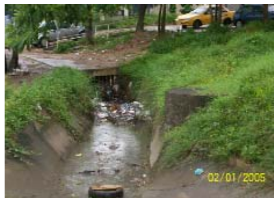
Figura 2.16. Box culvert abs. K00+290 sobre canal Santa Lucia
