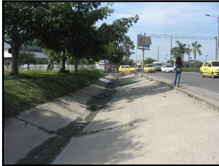
Foto D7.4 canal que recoge la escorrentía de Santa Lucia
