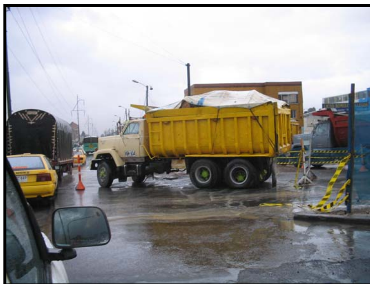
Foto D8.5 El transporte de materiales de relleno se realizará con empleo de volquetas debidamente carpadas (Adecuación de la Troncal NQS de Transmilenio en Bogotá)
