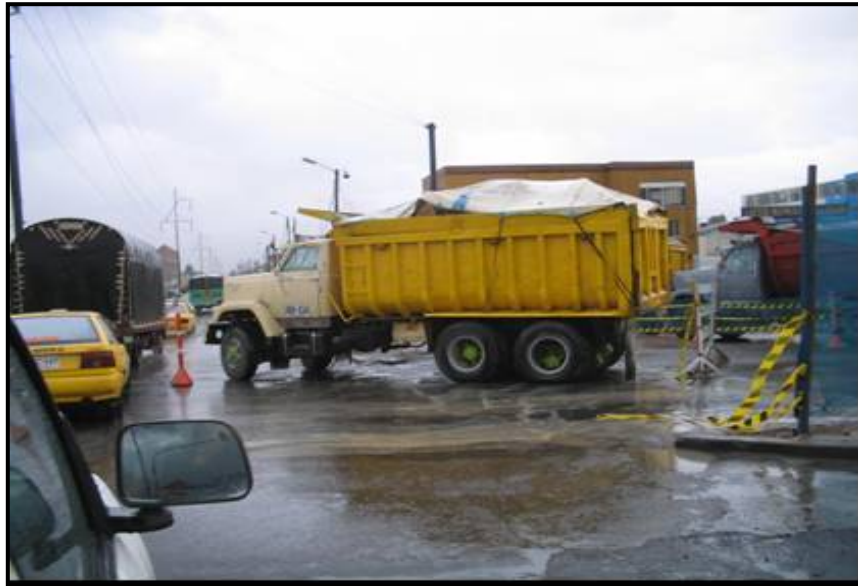
Foto D1.4 Los vehículos destinados al transporte de escombros no deben ser llenados por encima de su capacidad (a ras con el borde superior más bajo del platón), la carga debe ir completamente cubierta y amarrada con una lona. Obsérvese que la volqueta mostrada incumple con el requerimiento anterior. (Adecuación de la Troncal NQS de Transmilenio en Bogotá)
