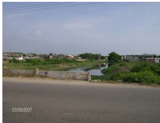
Figura 2.8. Vista del canal Matute sobre vía de la Cordialidad
