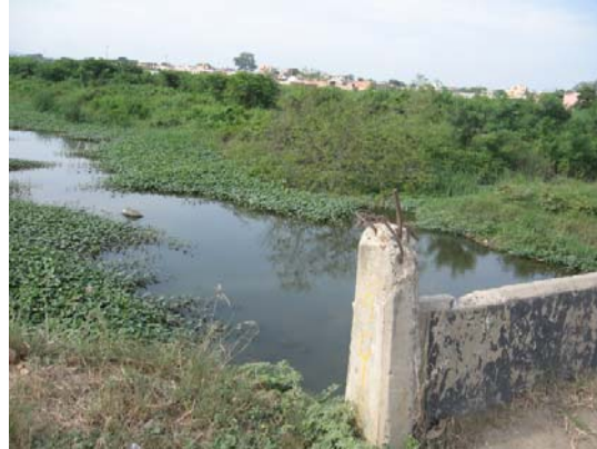
Figura 2.10. Box culvert ubicado sobre Vía de la Cordialidad
