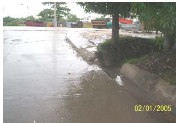
Figura 1.9. Canal Calle 31(Canal Cicon)
