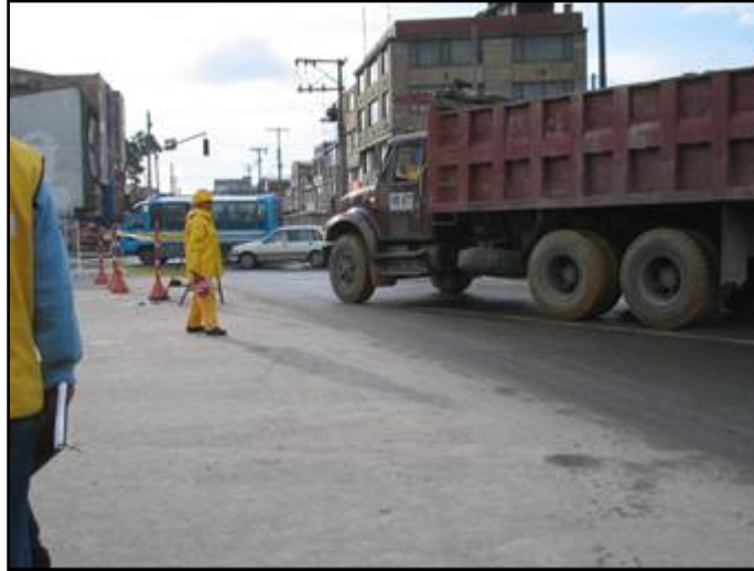
Foto D4.1 El uso de escoltas es obligatorio, así como el uso de paleteros para la entrada y salida de los equipos y maquinarias. (Adecuación de la Troncal NQS de Transmilenio en Bogotá)
