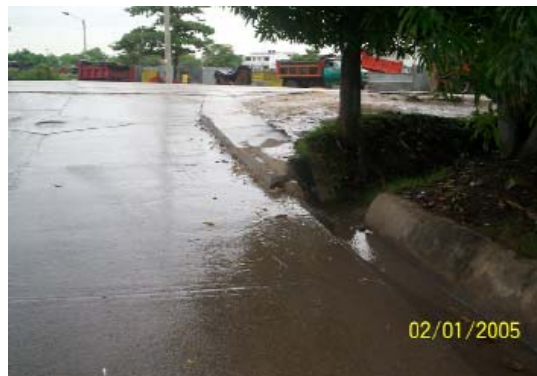
Figura 2.17. Canal que capta parte de la escorrentía del barrio Los Alpes
