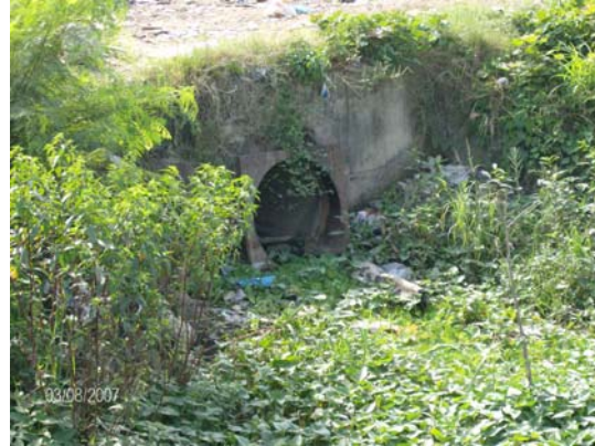
Figura 2.12. Vista del canal de drenaje del barrio Villa Rosita
