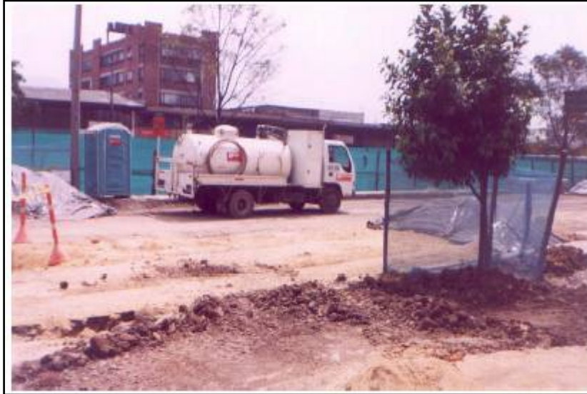
Foto D5.1 Cabina Sanitaria Portátil y Vehículo de Mantenimiento. Cuando se instalen cabinas de servicio sanitario en los diferentes frentes de construcción usados por el personal de la obra, (uno por cada 15 personas) será obligación de la empresa que las suministra encargarse del manejo y disposición de los residuos generados. (Adecuación de la Troncal NQS de Transmilenio en Bogotá)
